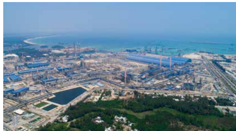
Nhà máy thép Hòa Phát tại Dung Quất, Quảng Ngãi do Hòa Bình làm thầu chính các hạng mục trọng yếu
