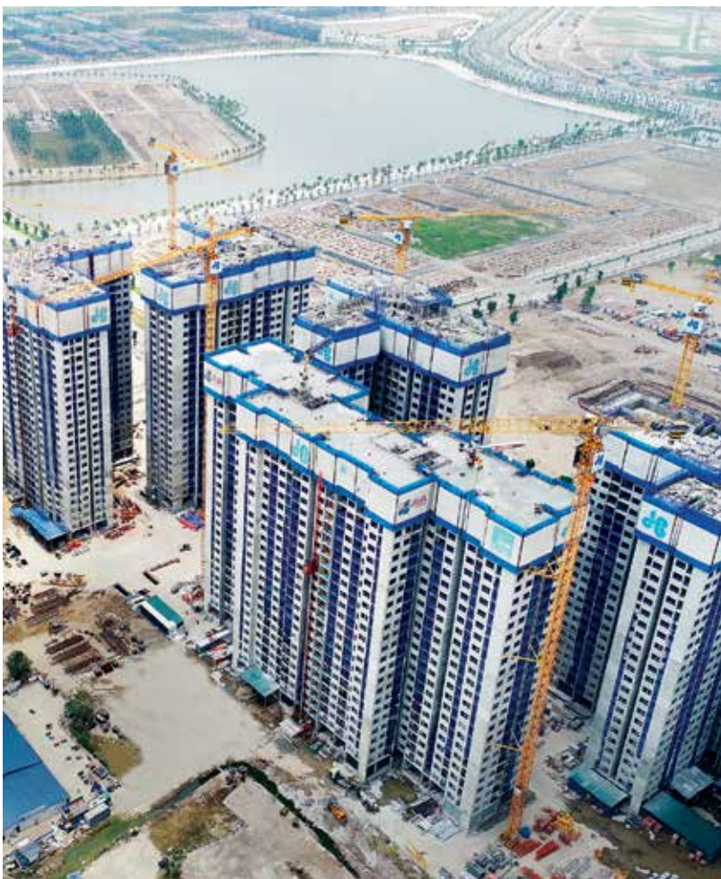
Công trình Vinhomes Ocean Park (Hà Nội) do Hòa Bình làm thầu chính 14 tòa tháp
