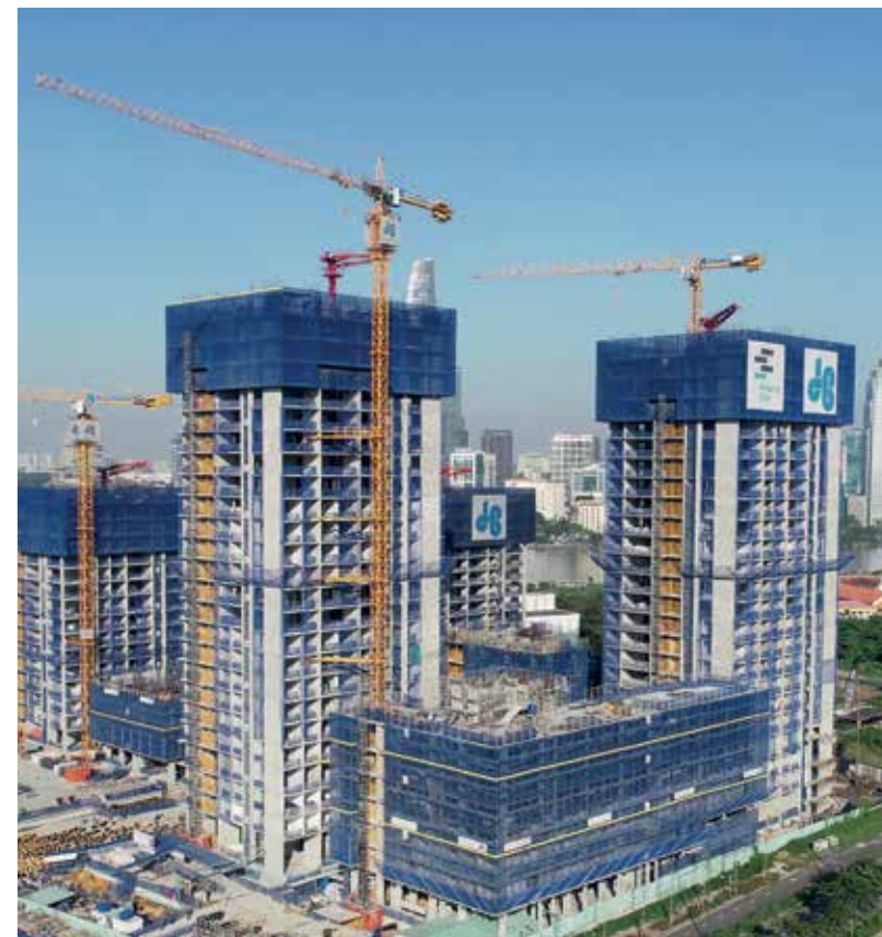
Công trình Empire City do Hòa Bình làm tổng thầu
