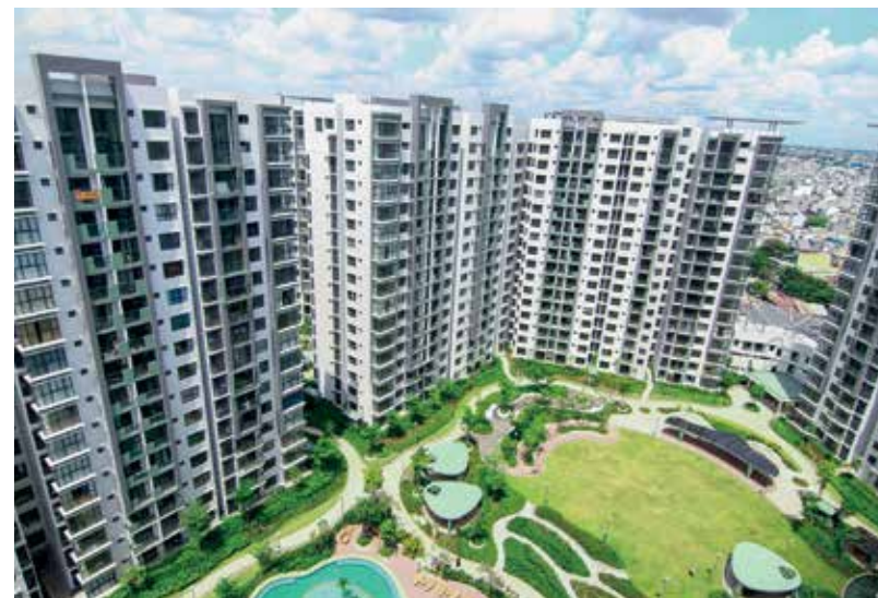
Công trình Emerald - Celadon City do Hòa Bình làm tổng thầu.
