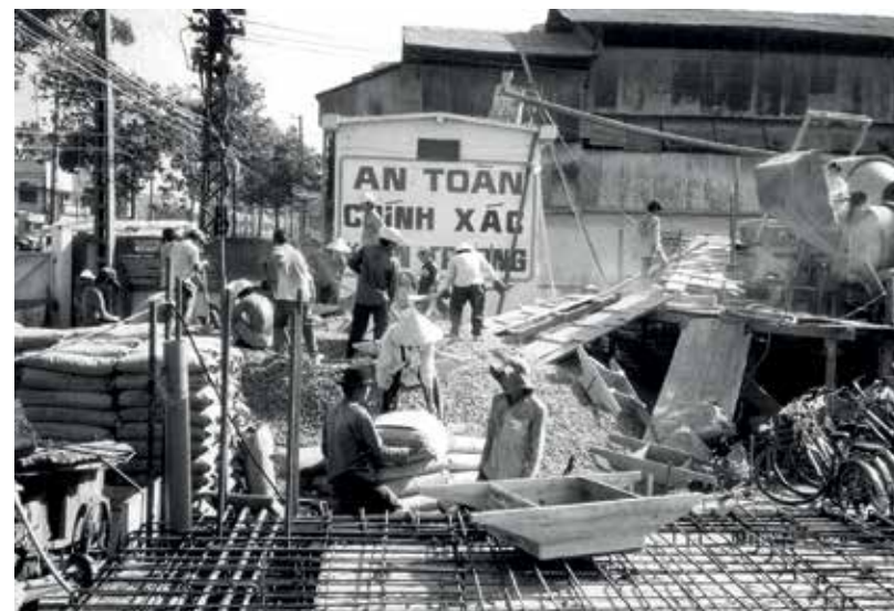
Đội ngũ công nhân Hòa Bình thi công công trình Food Center of Saigon (393 Trần Hưng Đạo, Quận 1, Tp.HCM) vào năm 1991.
