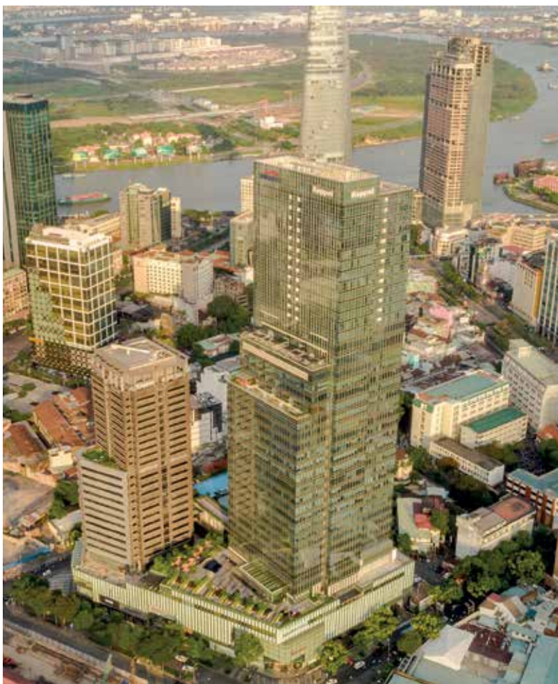
Công trình Saigon Centre do Hòa Bình làm tổng thầu.
